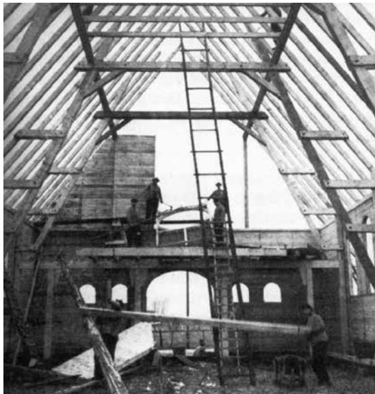
Während der Bauarbeiten
