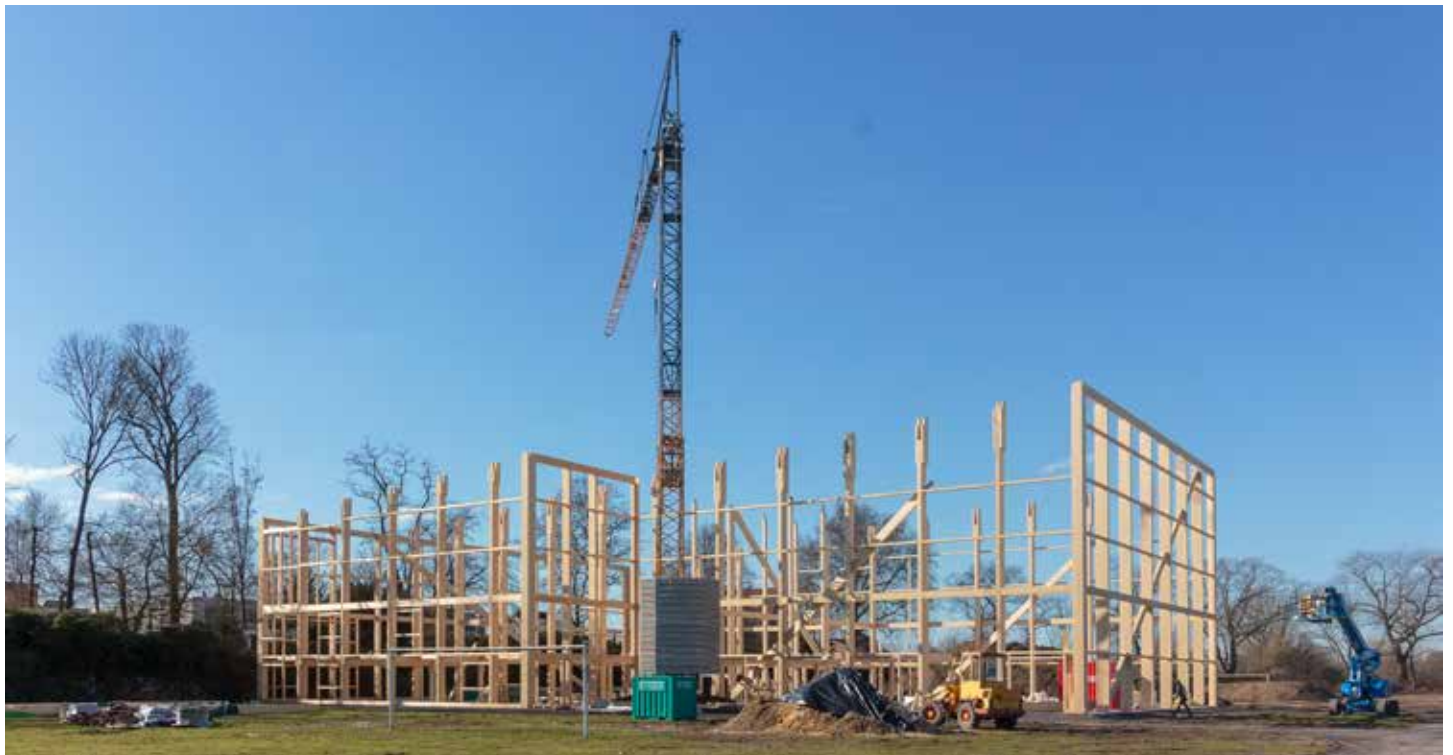
FOTOS / Die neue Kletterhalle an der Grevener Straße entsteht in Holzständerbauweise.
