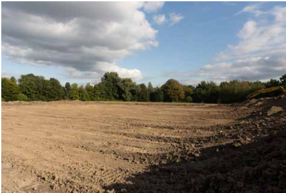
Hier entsteht das Regenrückhaltebecken.
