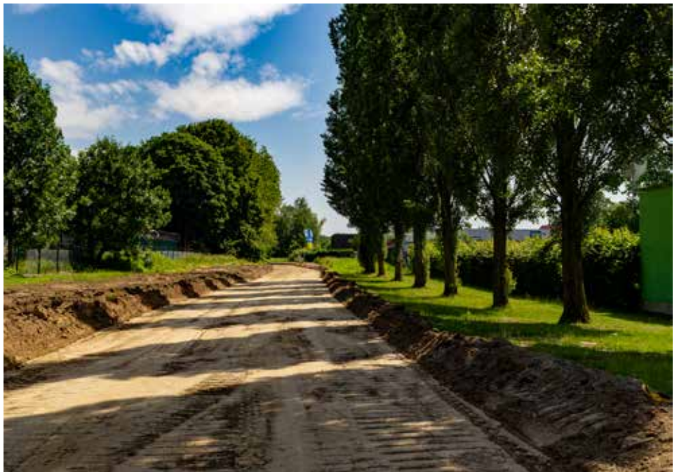
Die neue Baustraße hinter dem Freiherr-vom-Stein-Gymnasium.
