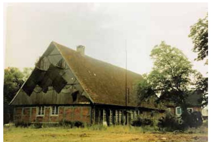
Hof Averkamp vor der Renovierung. Foto: Fachwerk
