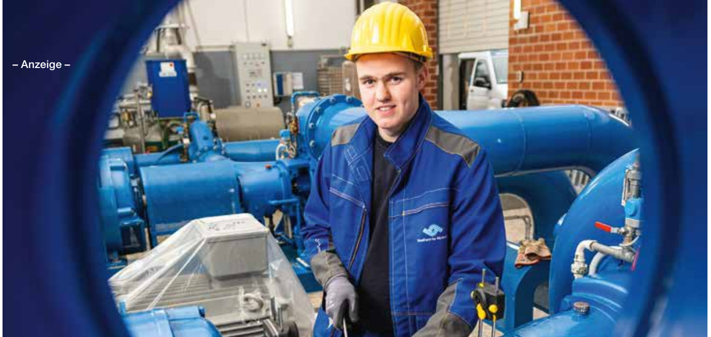
Ein Blick in das Wasserwerk Vennheideweg, einer der vielen Arbeitsorte von Damian Görtz.
